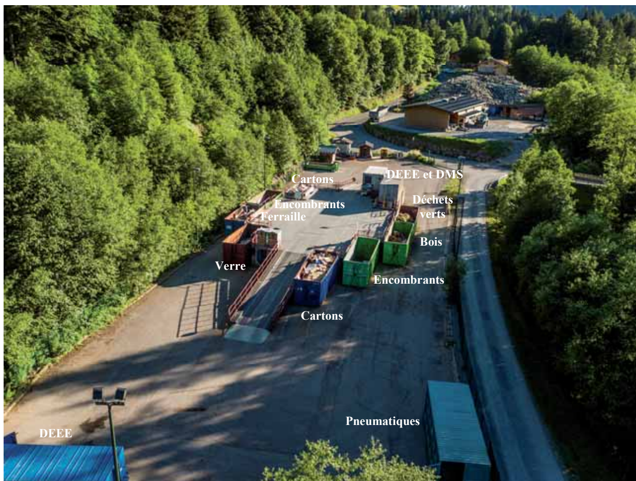
Photo 7 : vue aérienne de la déchèterie des Gets
