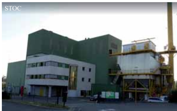
Photo 1 : usine d'incinération de Thonon-les-Bains
