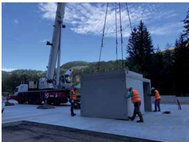
Mise en place des modules et haut de la plate-forme
