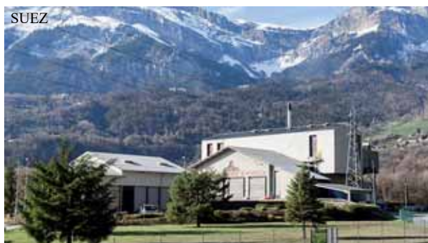
Photo 2 : usine d'incinération de Passy
