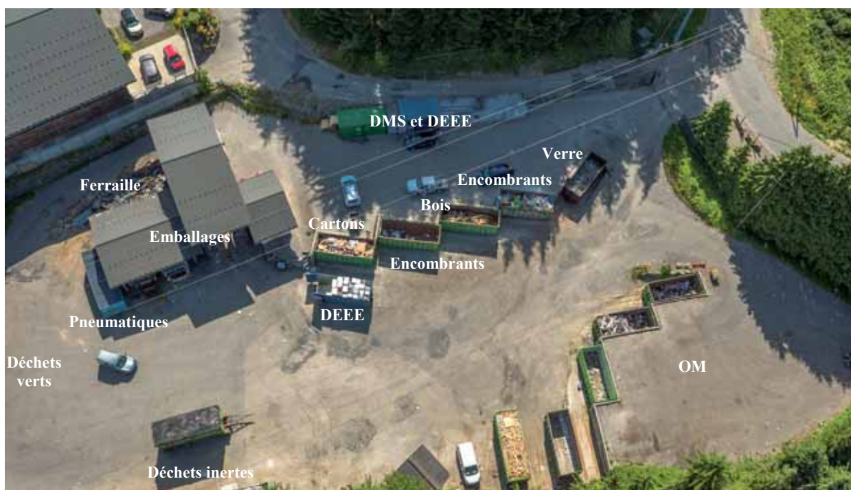
Photo 5 : vue aérienne de la déchèterie de Morzine
